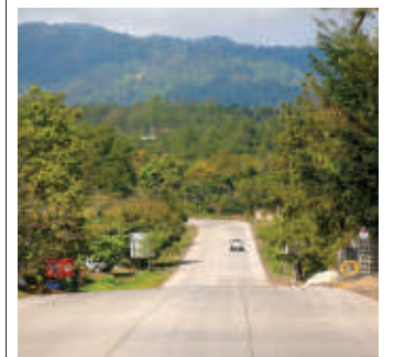
OBRA. Así queda el tramo carretera en occidente.
