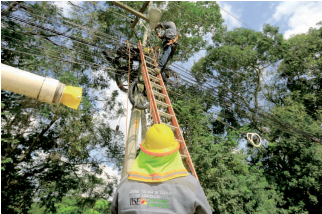
ESTATAL. Las pérdidas eléctricas de la Enee vienen desde el 20% en 2001, alcanzando casi el 40% en 2024. FOTO MOISÉS VALENZUELA
