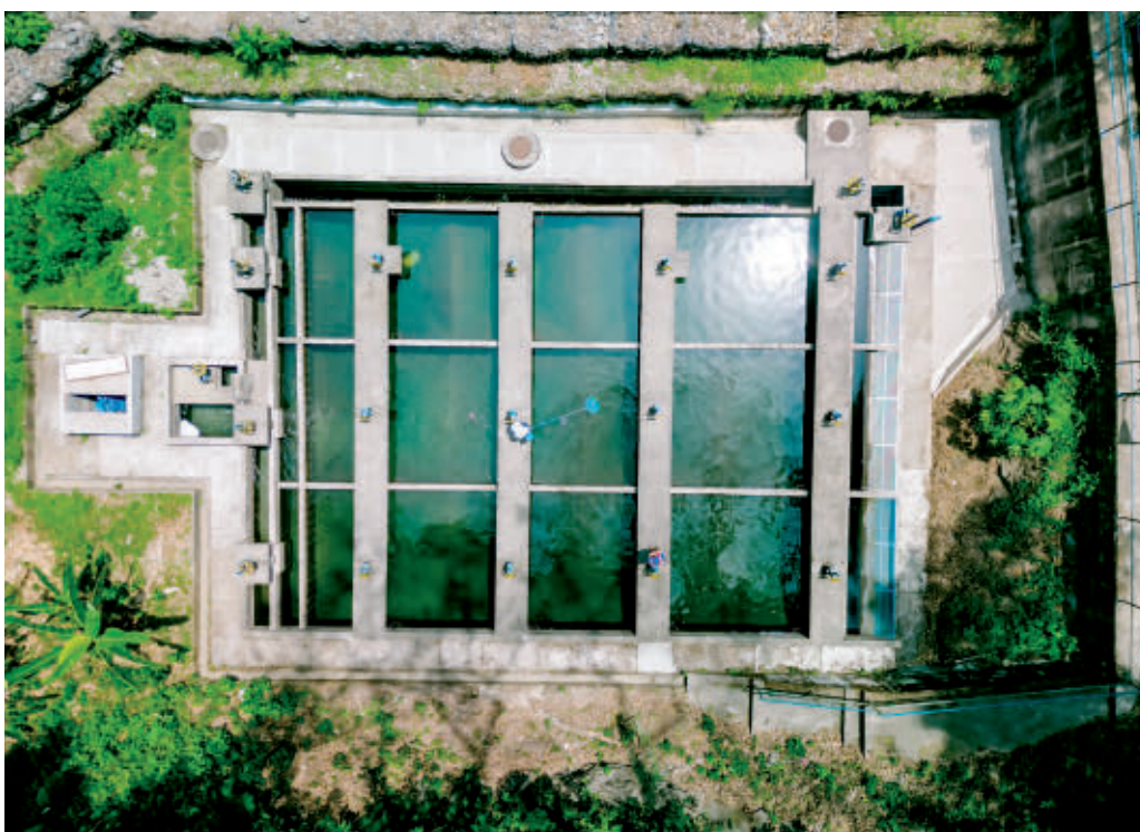
SERVICIO. Vista aérea de una de las plantas de tratamiento de agua potable de San Pedro Sula.
