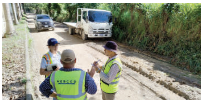
TRABAJOS. El personal de la empresa Hercod define la logística a implementar para el inicio de la pavimentación de la calle hacia Cacao.
