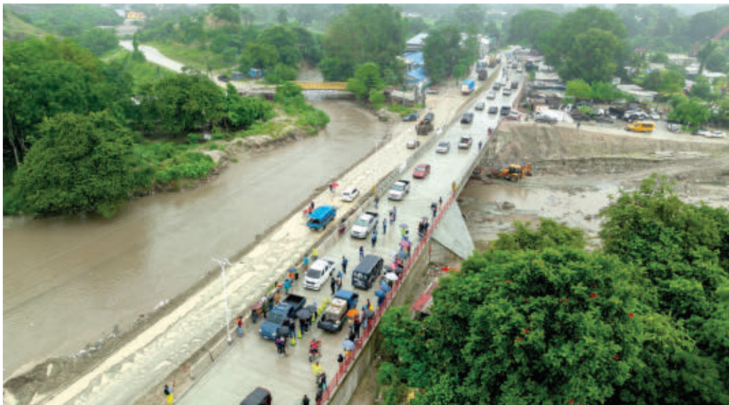
PROYECTO. El puente es la única obra construida en ese tramo Jucutuma-SPS; adonde se espera el bulevar de cuatro carriles y un puente más.
