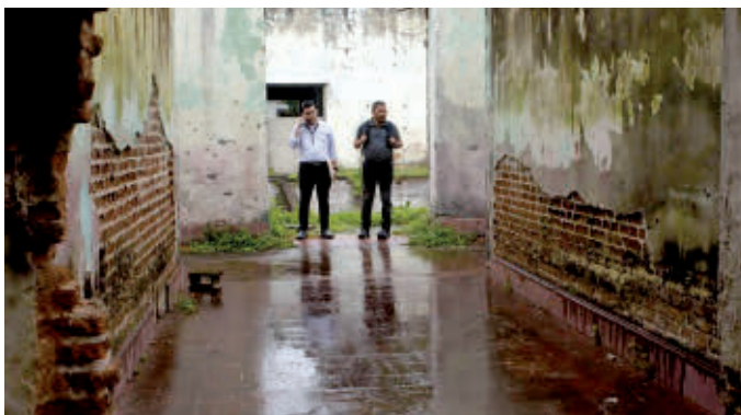
SUPERVISIÓN. Equipo técnico de la Secretaría de Educación en una inspección hecha la semana pasada en el inmueble.
