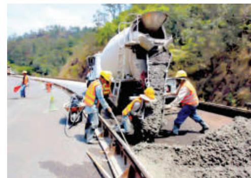
TRASLADO. Gran parte de los fondos estatales se redirigieron a obras de infraestructura vial el año pasado.
