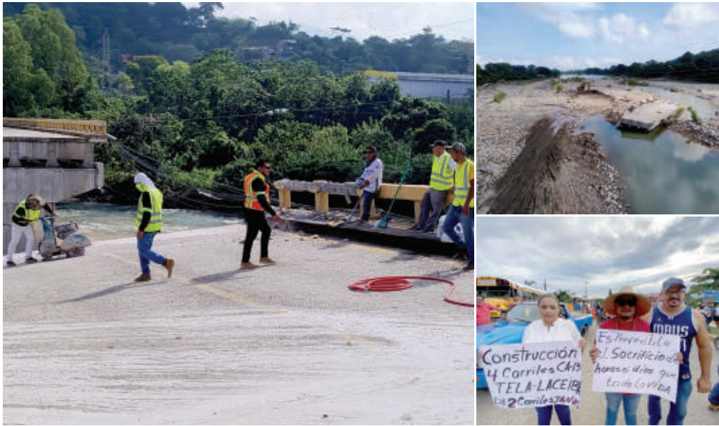
TRABAJOS. Obreros comenzaron a demoler la losa dañada; más temprano los ceibeños protestaron.
