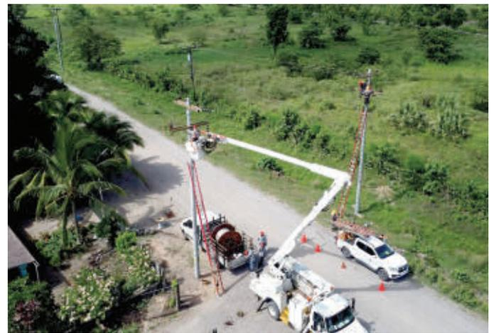
**INFRAESTRUCTURA.** Construcción de un kilómetro de línea primaria para la reconfiguración del circuito ISL345.
