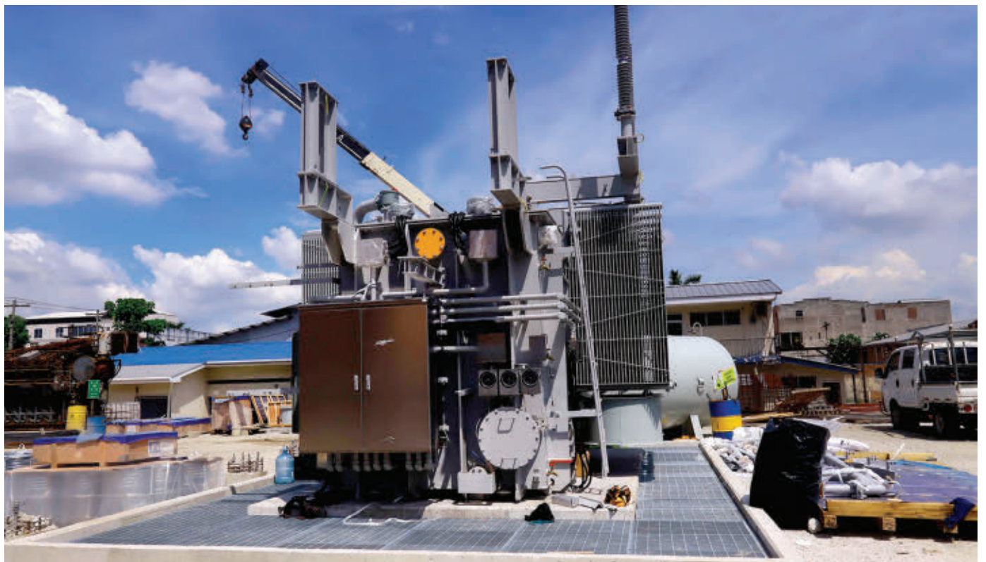
PROYECTO. San Pedro Sula-Centro se llama la nueva subestación que construye la Enee en barrio El Benque. FOTO: MELVIN CUBAS.
