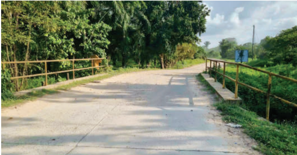
OBRA. Desde este punto iniciará la pavimentación de los primeros tres kilómetros.
