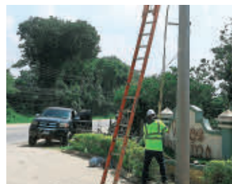
LABOR. Cuadrillas de la Enee trabajan en el tendido eléctrico.
