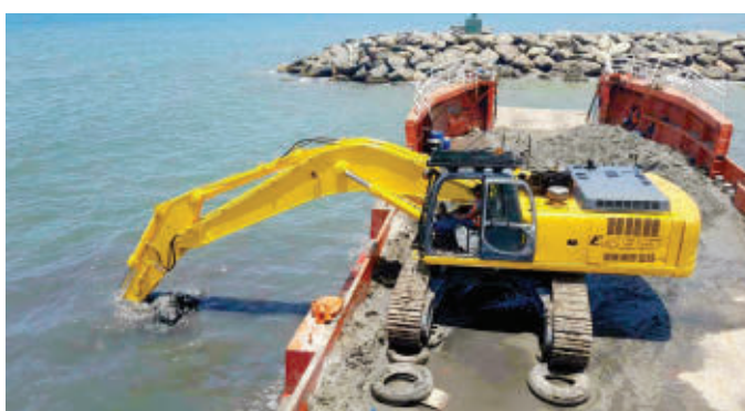
BOCANA. Los trabajos de dragado van con buen tiempo.
