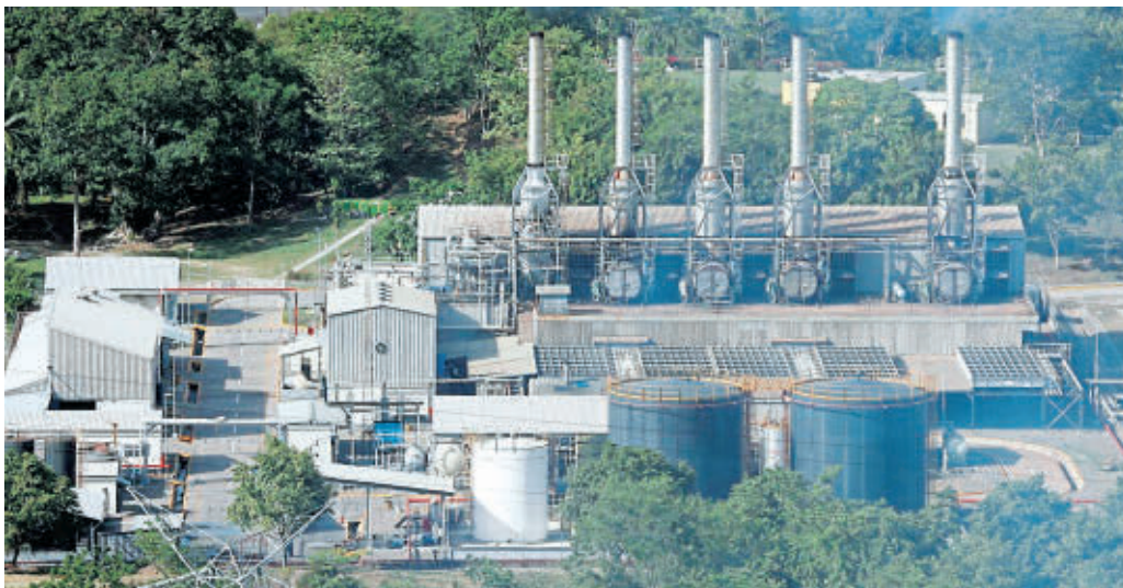
TÉRMICAS. Una planta térmica en operación en la zona norte del país.
