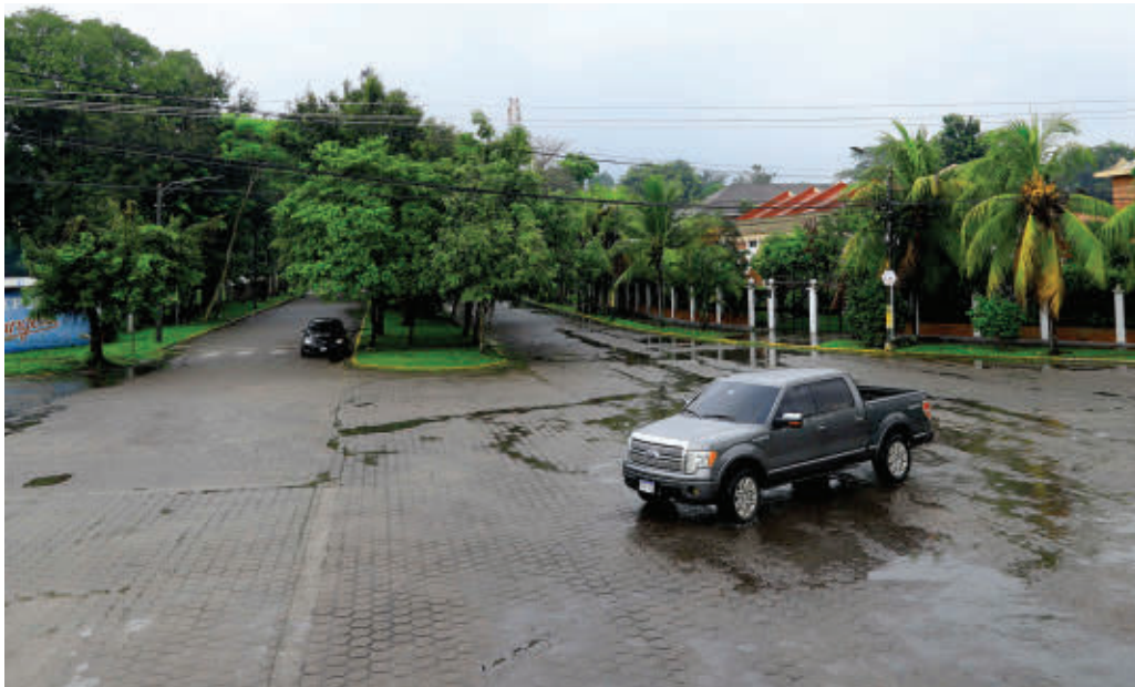
OBRA. En la prolongación de este bulevar se construirá el puente sobre el río Santa Ana.
